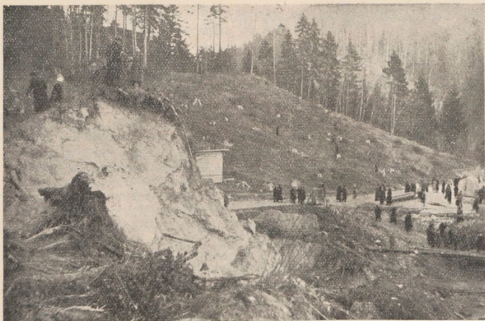
Glissement de terrain près de Lausanne. La route Lausanne-Belmont coupée par un glissement de terrain.
