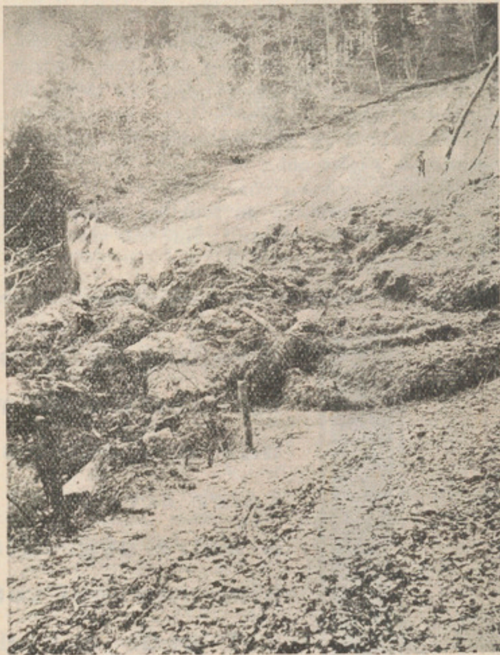
Un chemin vicinal recouvert par une glissée.
